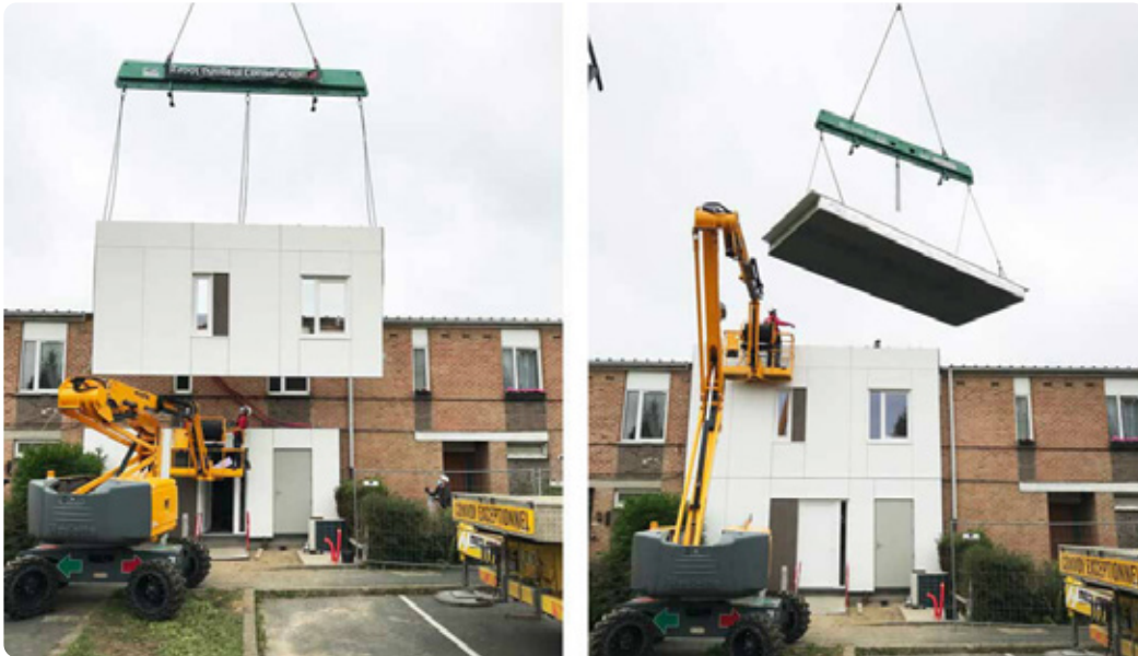
BuildUp heeft prefab-oplossingen om grootschalige energierenovaties door te voeren.
