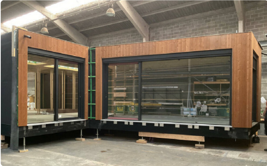
STIDO kiest voor verplaatsbare, aanpasbare en duurzame houtskeletbouw, prefabricatie en lokale leveranciers. Dat leidt tot meer efficiëntie, een beperkte CO 2 -uitstoot en minder afval.
