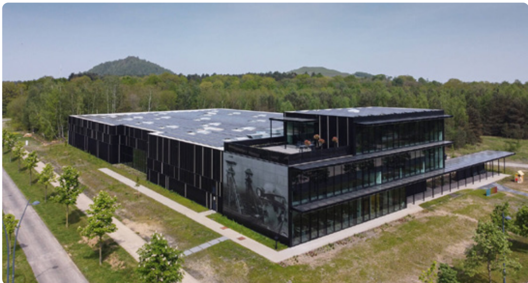
Het SOLTECH-gebouw met productiehal op Thor Park in Genk. De award winnende gevel met de mijnwerker wekt zonne-energie op, net als de overkapping, zonnewering en balustrade van het dakterras. Het dak ligt vol met standaardpanelen die samen met de BIPV en de energiebesparende maatregelen zorgen voor een energieneutrale productie en een EPC-waarde van -4.
