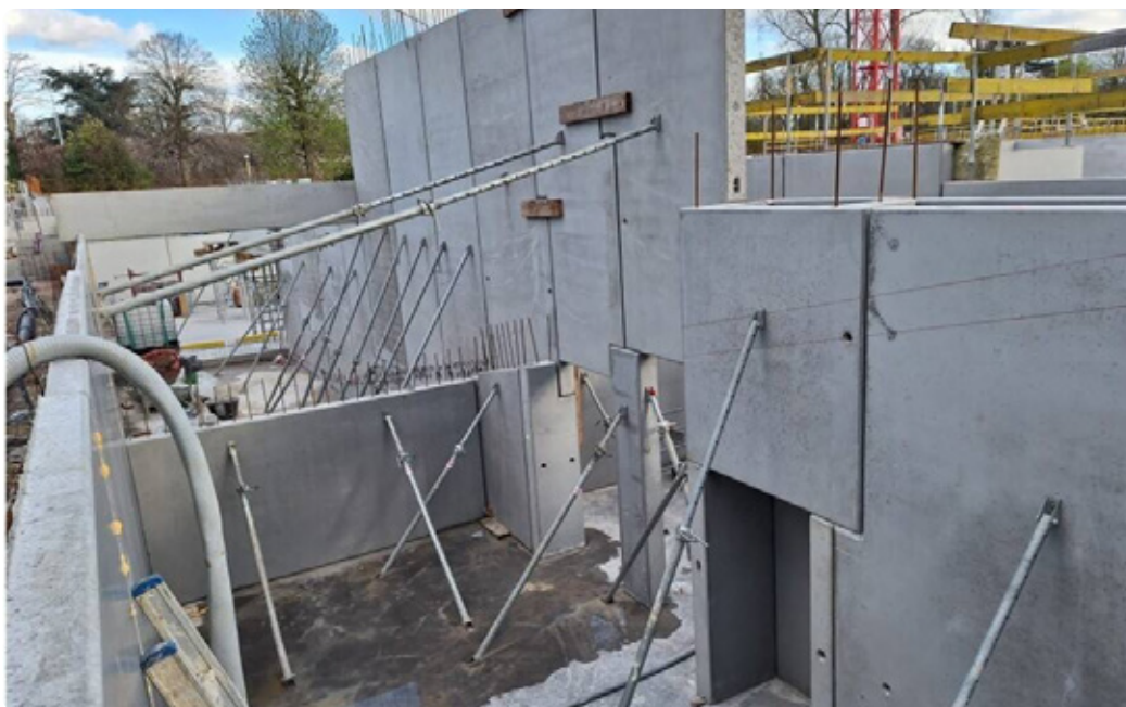
Bij de nieuwe Brugse stadswijk Boevrie leidde een uitstekende in-house digitale voorbereiding tot een gestroomlijnde productie, levering en plaatsing van prefab bouwelementen (afbeelding Furnibo).
