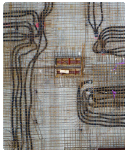
Vooraleer leidingen in beton verdwijnen kunnen ze in kaart worden gebracht met een drone.
