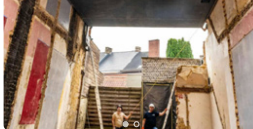
Inschuifwoning van Mobble, bestaande uit 2 modules en een zadeldak, geleverd en geplaatst te Zottegem.
